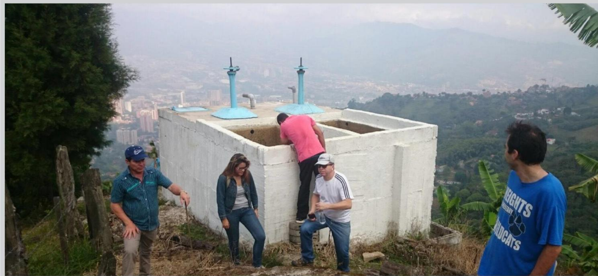
Mantenimiento y reparación planta de tratamiento aguas residuales. Vereda Las Lomitas, sector Los Congojos.
