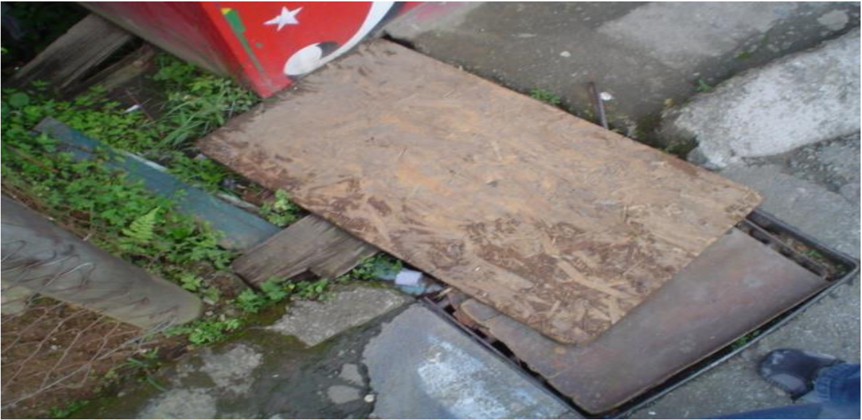
Figura 1. Aquí se muestra el sumidero existente a donde descarga la Quebrada mediante tubería.
